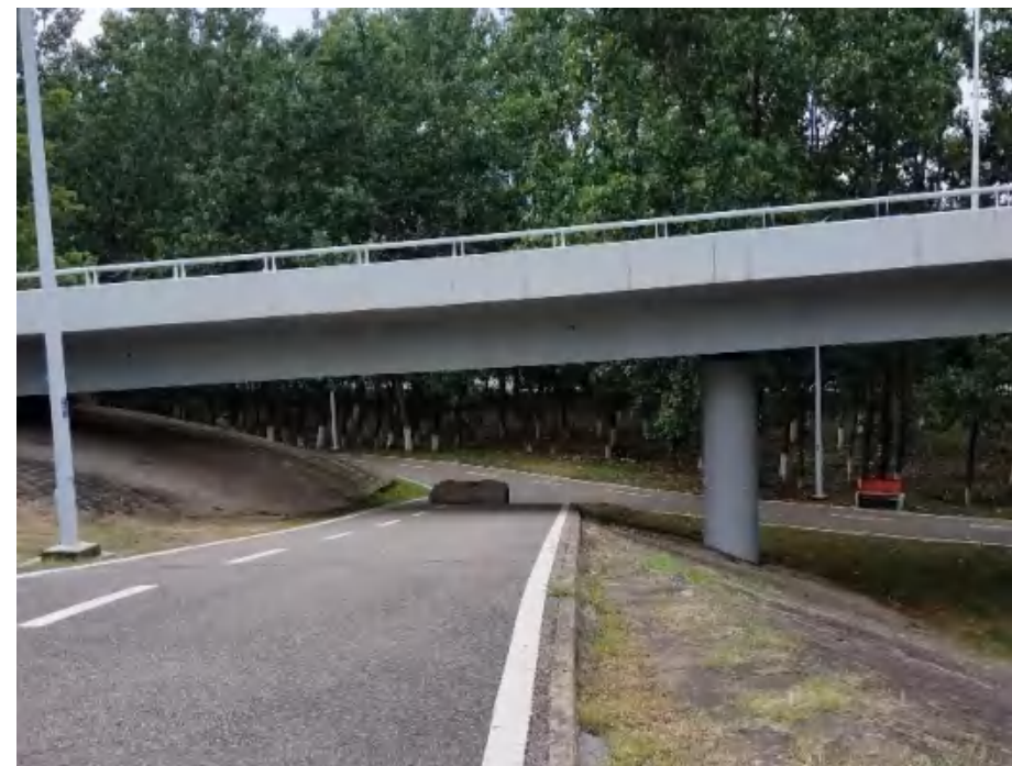
马城南路南侧张公堤绿道
