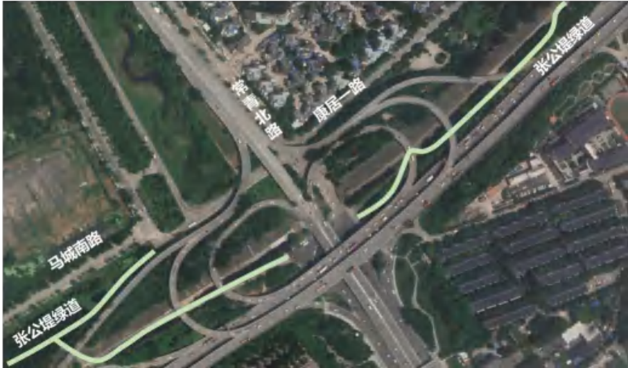
常青立交现状绿道情况
