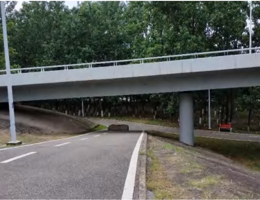
马城南路南侧张公堤绿道
