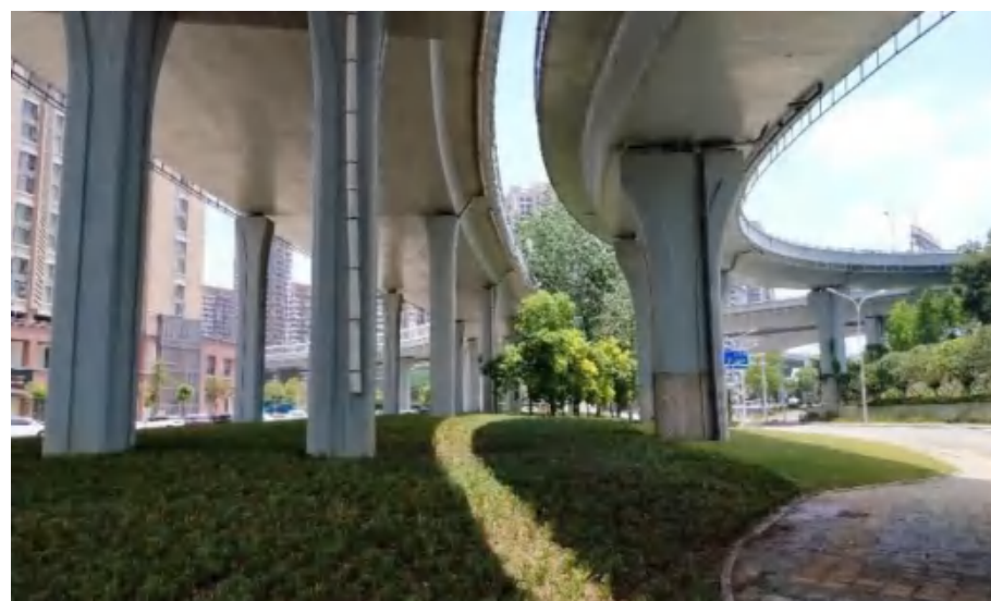
康居一路北侧桥下空间
