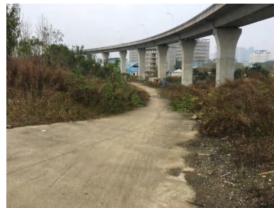
竹叶海立交东侧三环线匝道及便道
