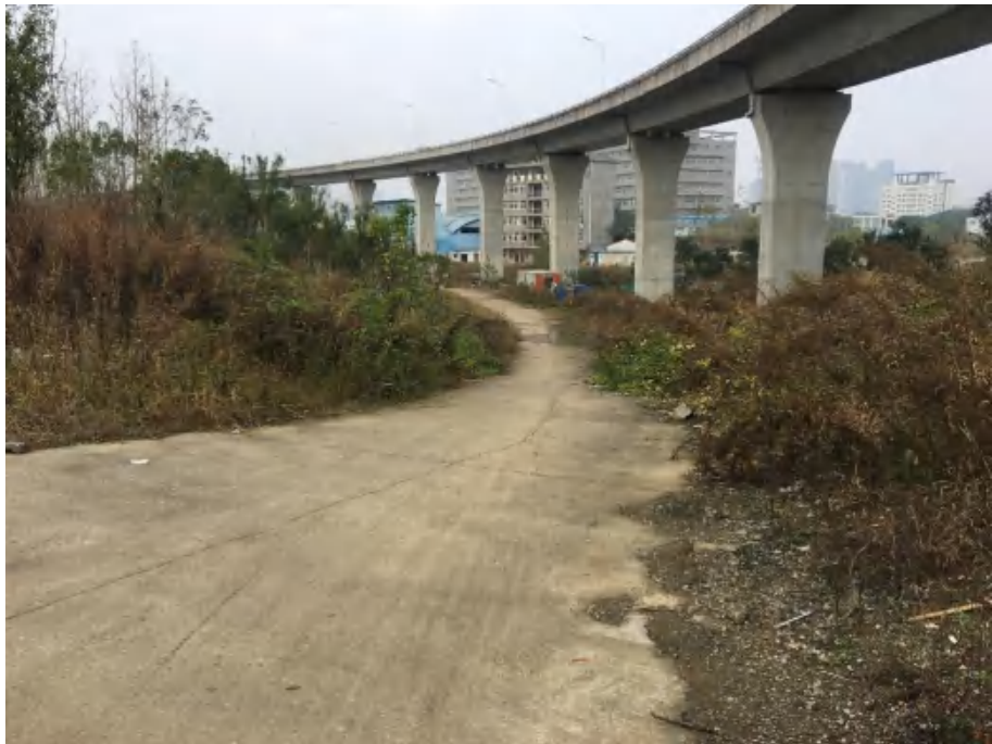
竹叶海立交东侧三环线匝道及便道
