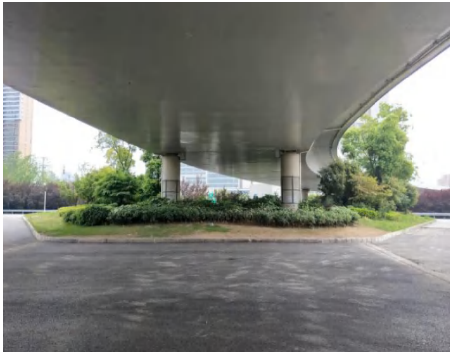
金南一路高架地面段
