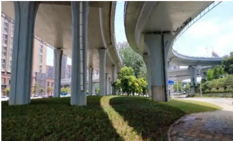
康居一路北侧桥下空间
