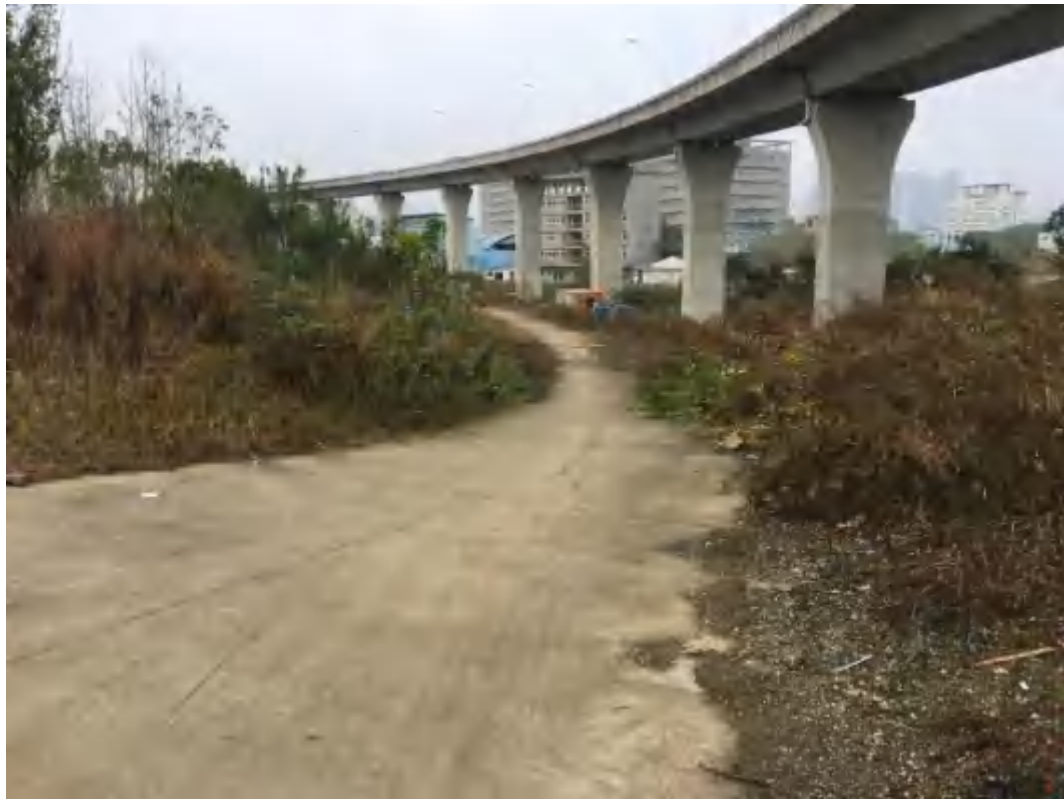
竹叶海立交北侧匝道下便道现状
