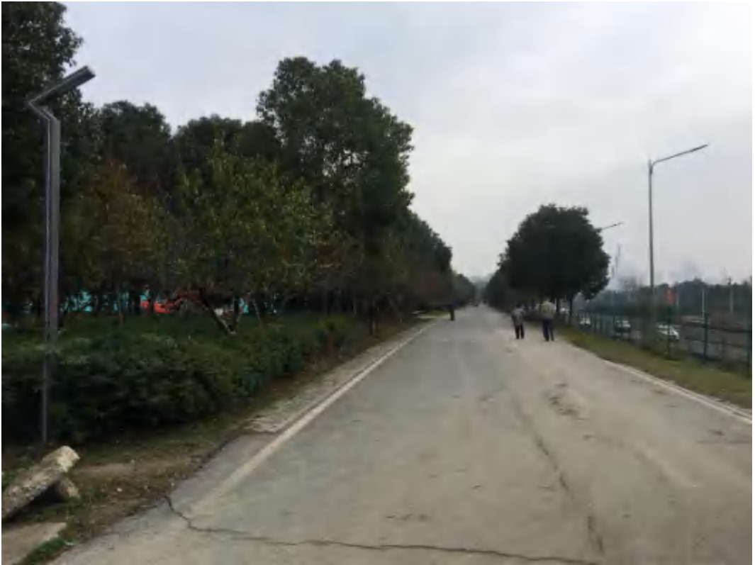
竹叶海立交东侧现有张公堤绿道
