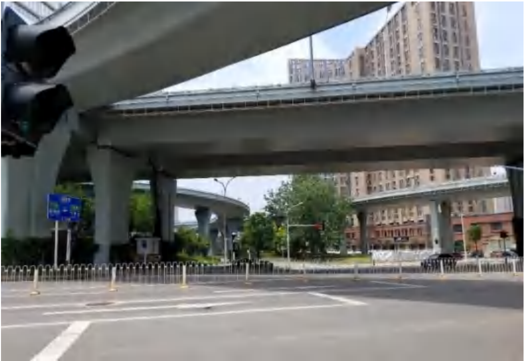
现状姑嫂树立交地面段
